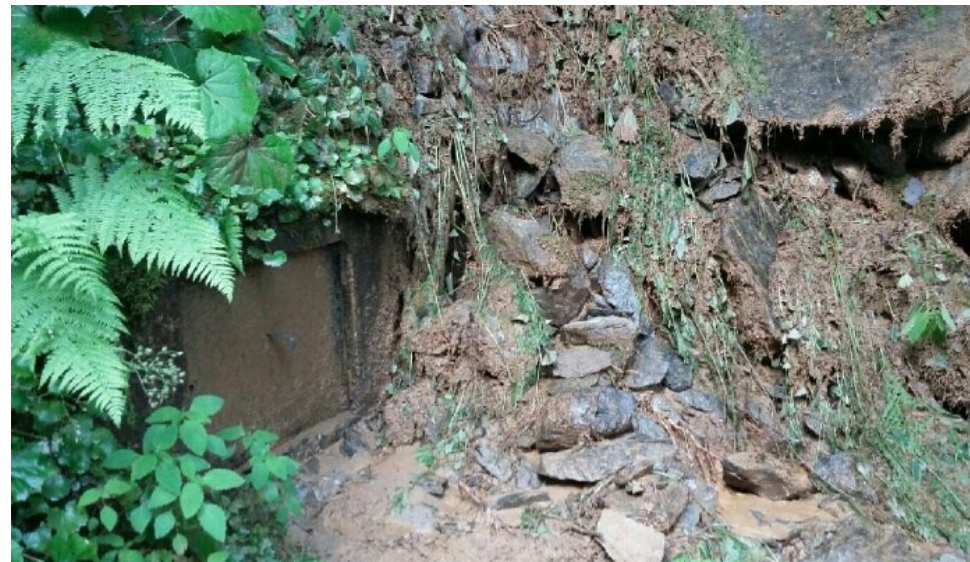
Pénétration de la boue dans le captage S4
